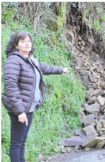
La frana del Sugame verrà sistemata a fine anno. Dopo tre anni di attesa apre il cantiere (Foto archivio)
